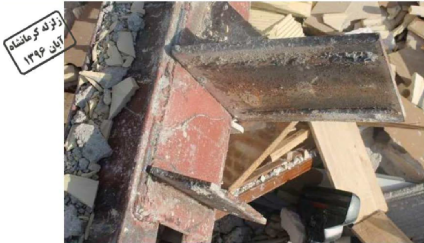
شکل ۵-۳۵ عملکرد نامناسب اتصال گیردار
