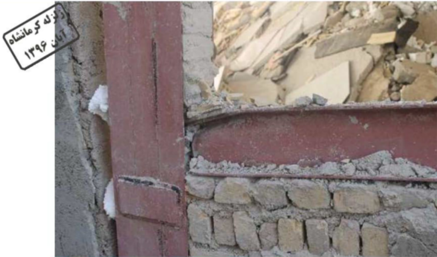
شکل ۵-۲۵ کمانش جان تیر در محل اتصال
