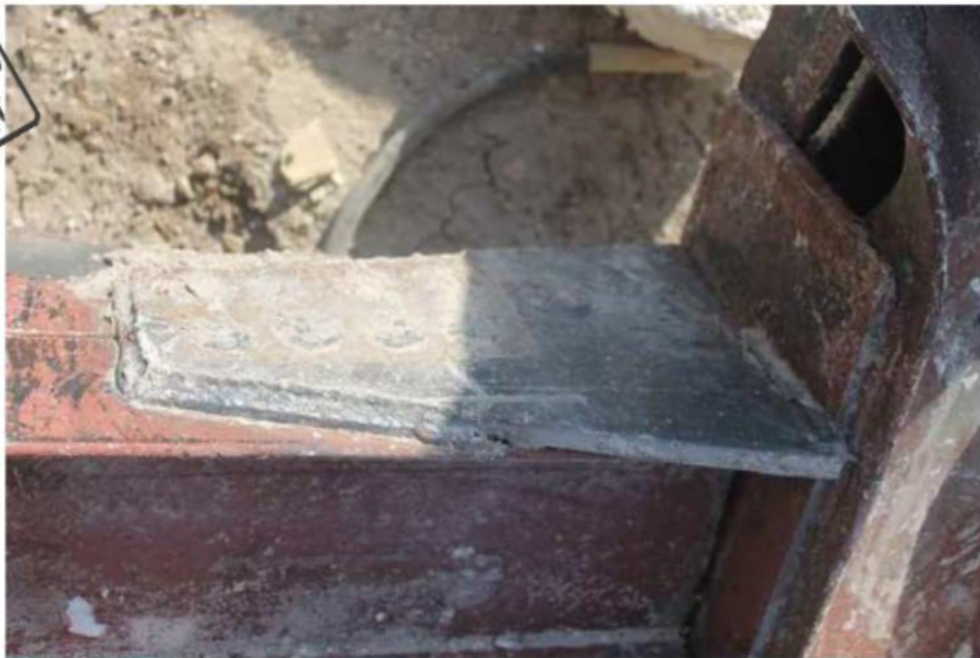
شکل ۵-۳۹ عملکرد مناسب صفحه اتصال گیردار
