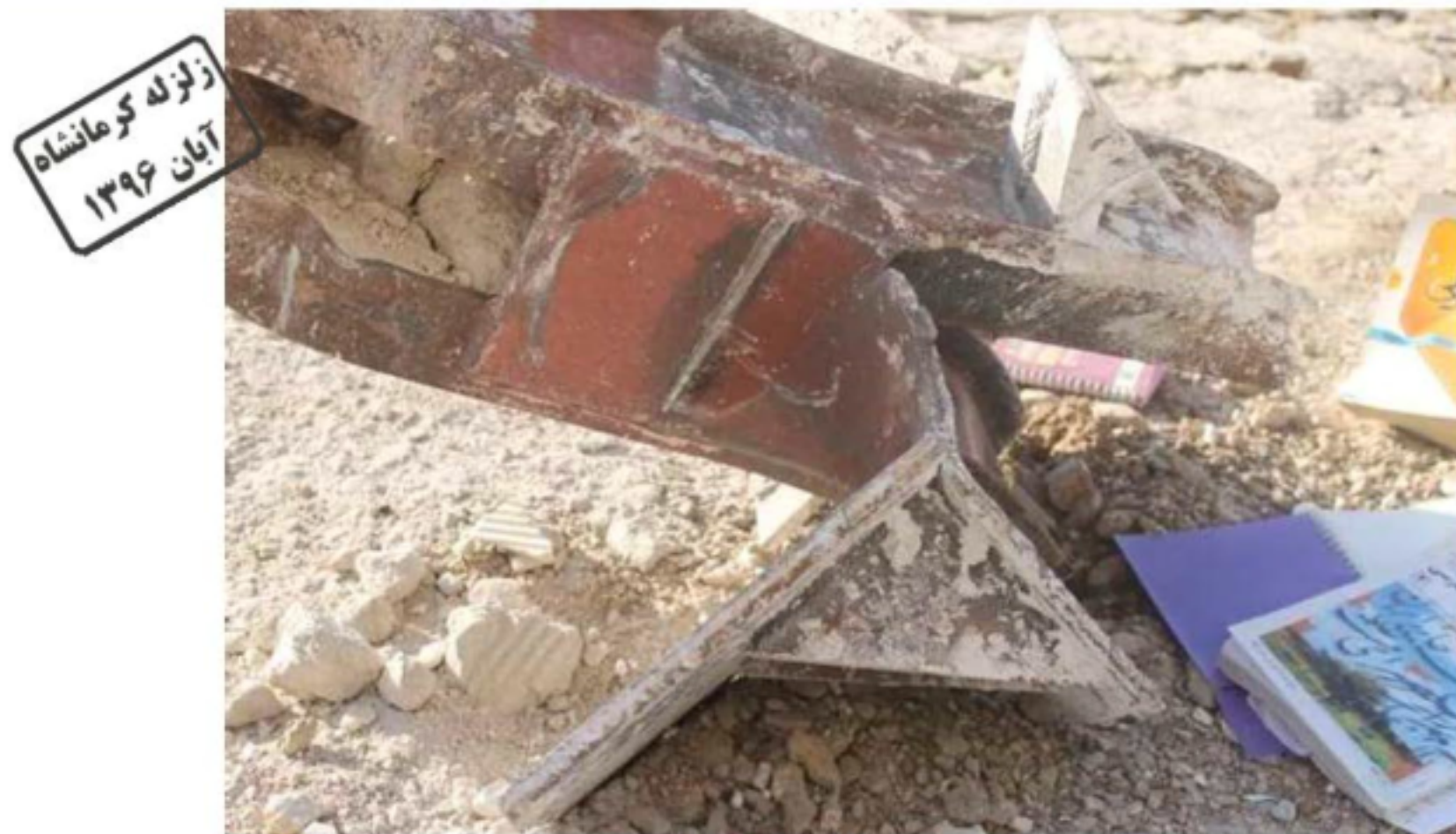
شکل ۵-۳۷ پارگی صفحه اتصال به ستون دارای بست مورب
