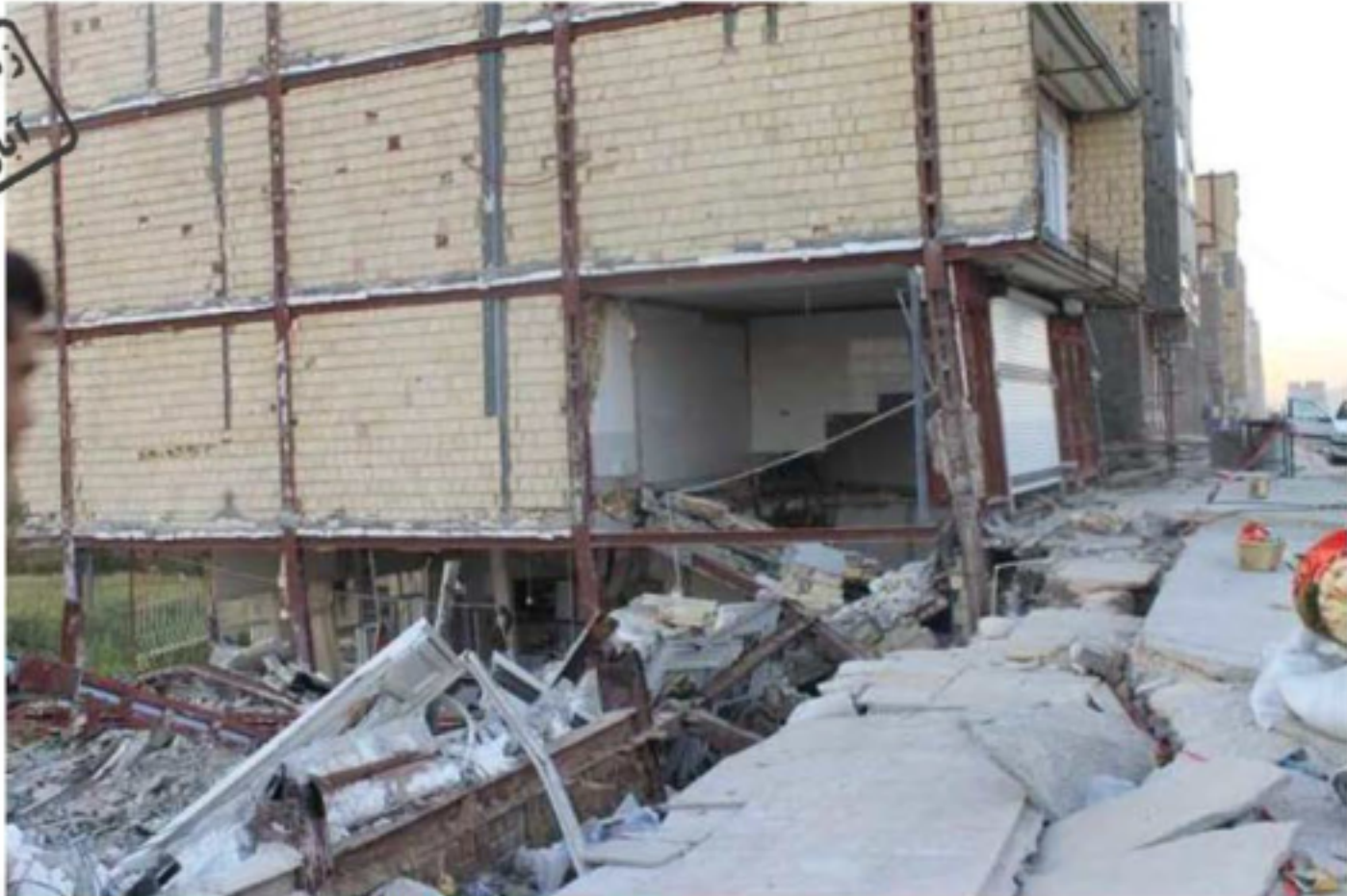
شکل ۵-۲۷ تغییر مکان جانبی بسیار زیاد و کنده شدن اتصال تیر به ستون
