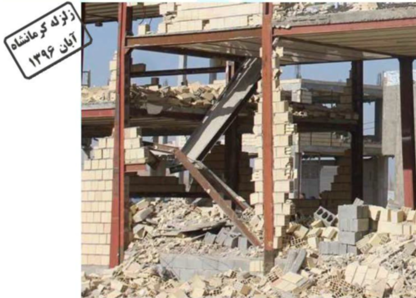
شکل ۵-۲۴ کنده شدن اتصالات تیرهای شمشیری راه پله
