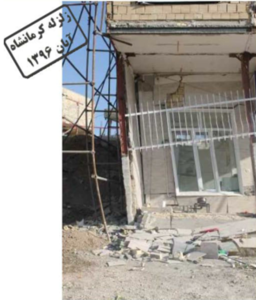
نمونه تغییر مکان جانبی زیاد در دو جهت
