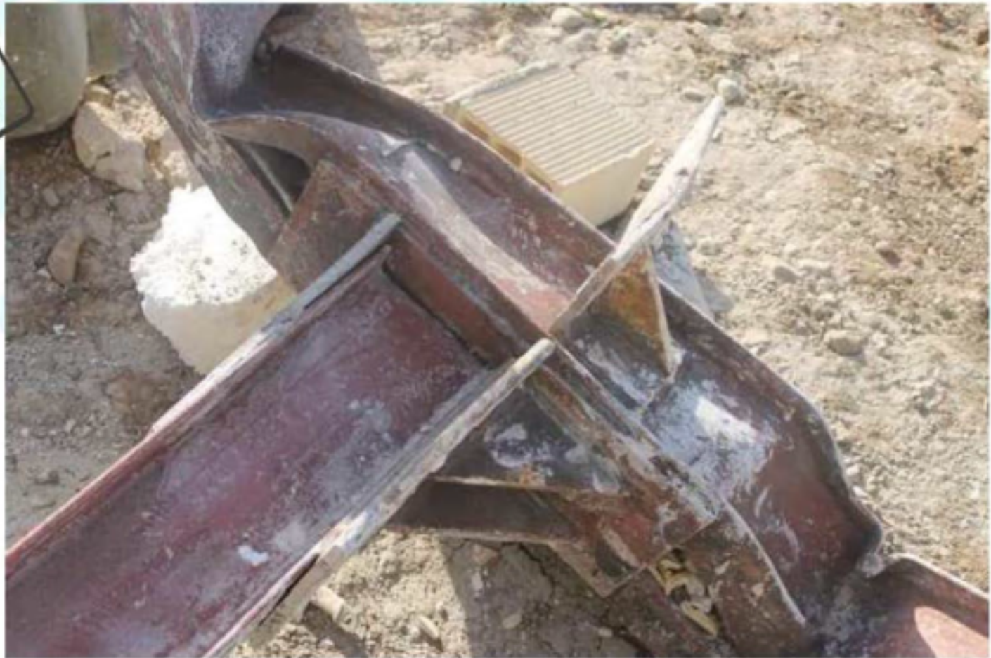
شکل ۵-۳۸ عملکرد کلی مناسب اتصال گیردار
