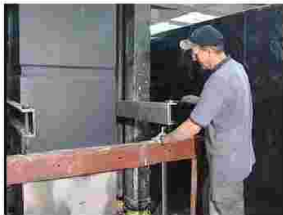
شکل ۶-۱۸ - نصب سازه خرابایی نگهدارنده
