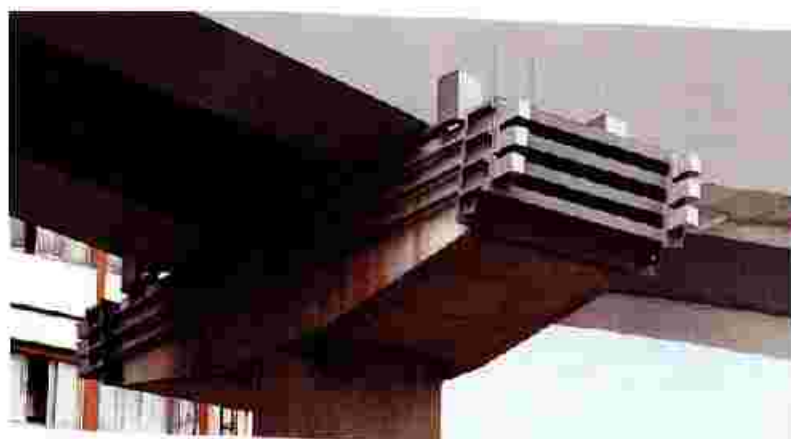
شکل ۲-۴-۱۹- روش استفاده از بیش‌تندگی کلی در مقاوم‌سازی تیرها
