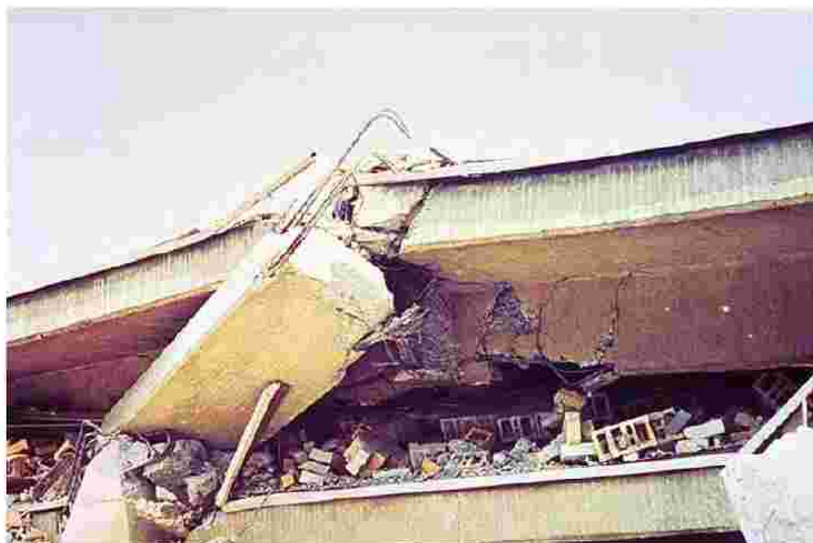
شکل ۲-۶-۱۰ وجود درز سرد در محل اتصال
