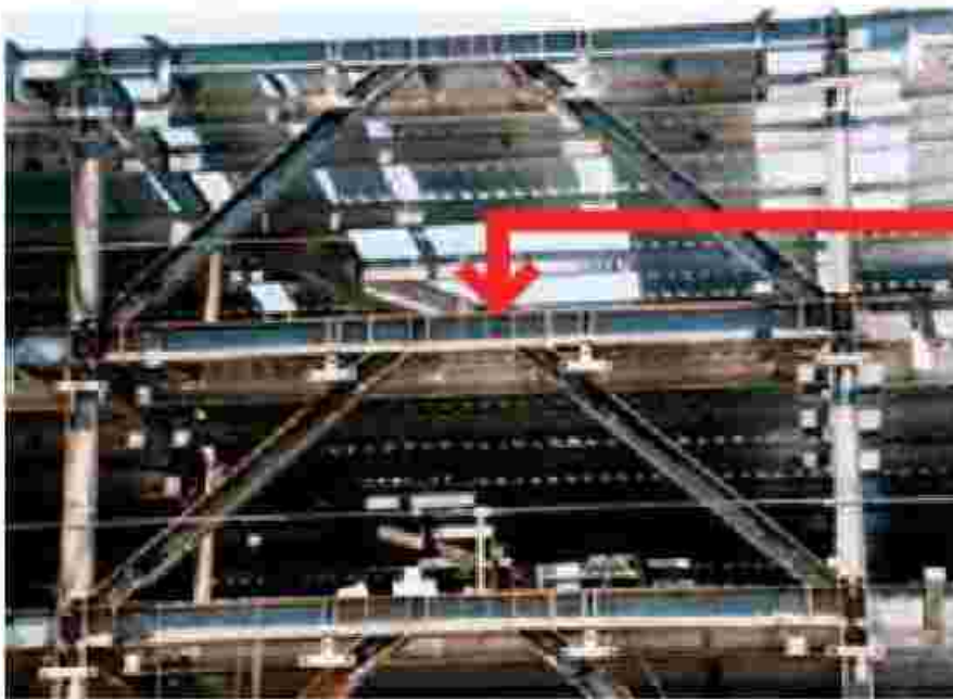
شکل ۴-۱۲- مهاربند واگرا و همگرای جناغی
