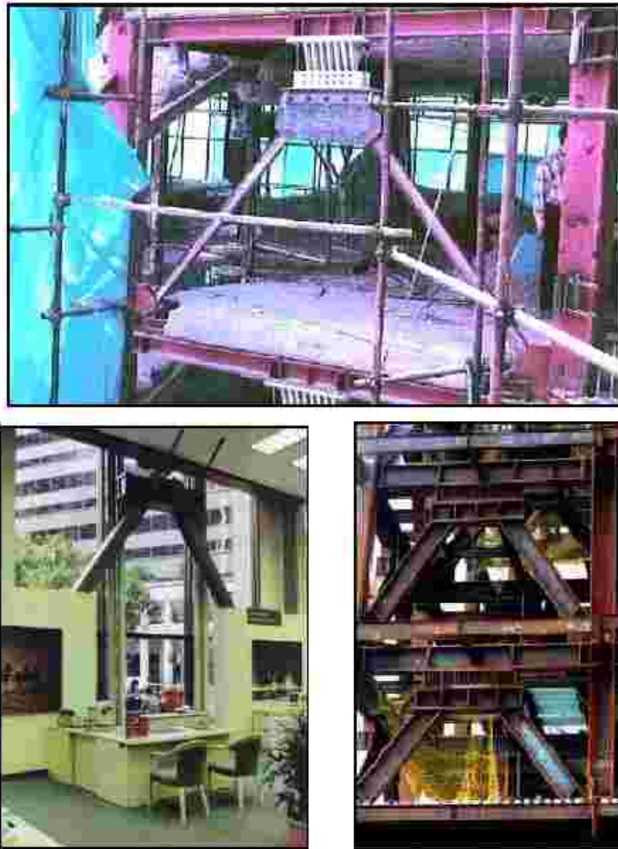
شکل ۷-۱۳- نمونه هایی از یکارگیری میراگر T-ADAS
