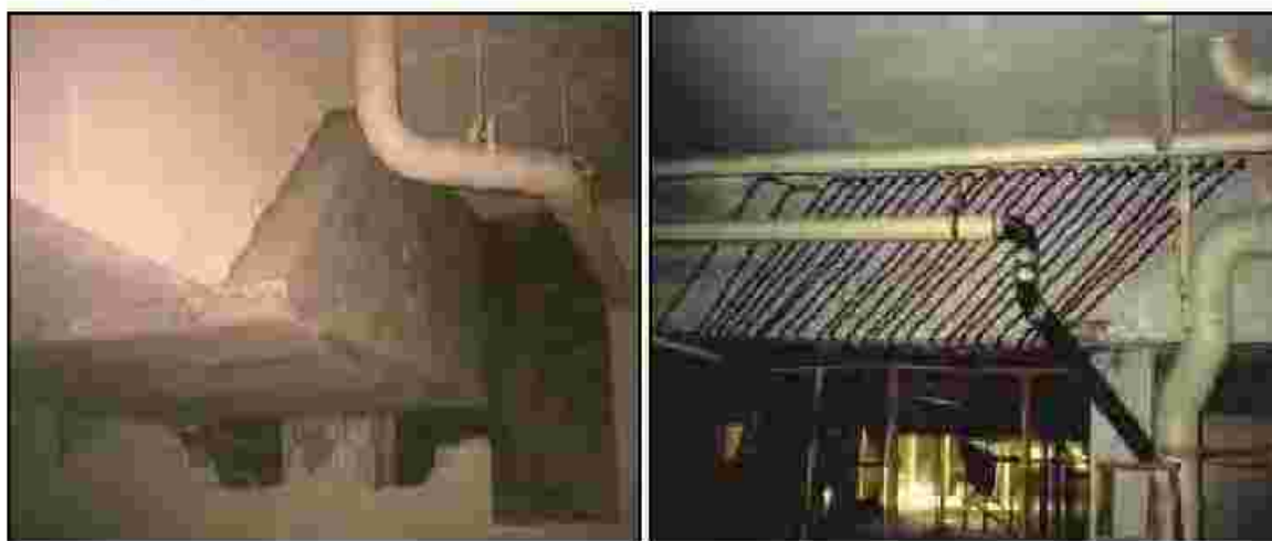
شکل ۲-۴-۴- استفاده از روکش بتنی در مقاوم‌سازی تیرها
