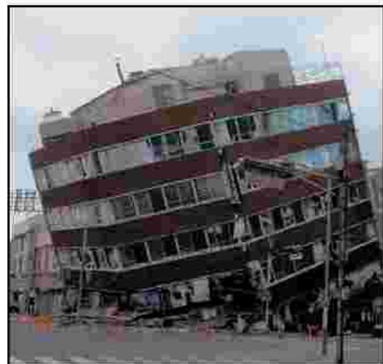
شکل ۳-۶- فاصله زیاد بین مرکز جرم و مرکز سختی و خرابی ناشی از ایجاد پیچش
