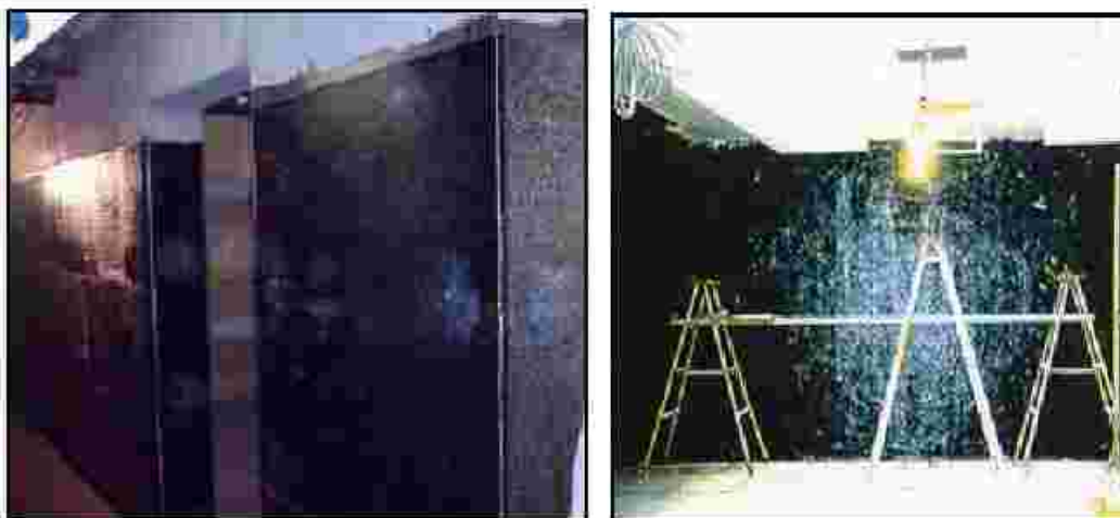
شکل ۴-۴۲- تقویت کلی دیوارهای برشی بوسیله مصالح FRP
