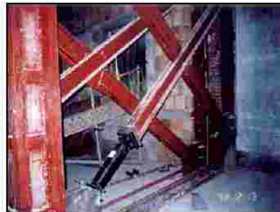
شکل ۷-۱۹- استفاده از میراگرهای ویسکوز در بادبندهای قطری
