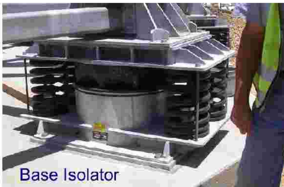
شکل ۶-۱۲- جداگر GERB
