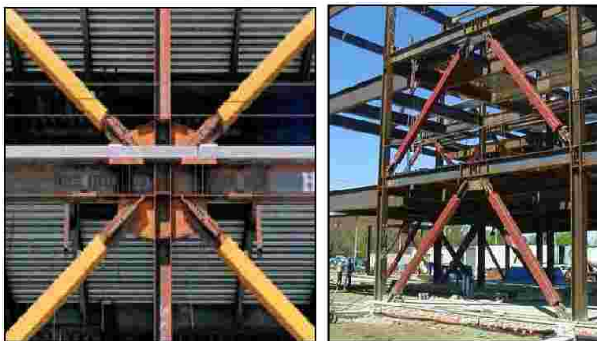
شکل ۴-۱۹- نمونه‌هایی از مهاریند ضد کماتش BRBF
