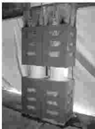
شکل ۶-۲۱- اتصال ستون‌های درز انبساطی در بالا و پایین سطح جدا شده
