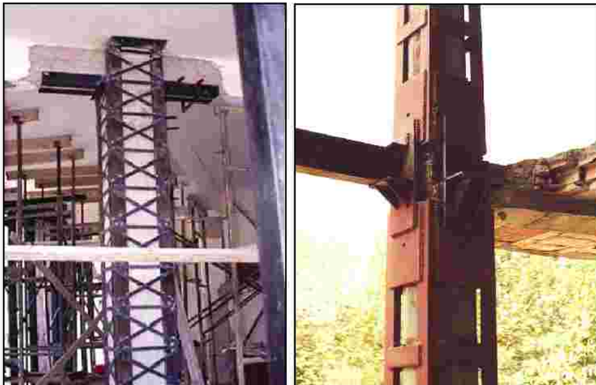
شکل ۲-۶-۲۵ روش‌های بهسازی اتصالات مابنی
