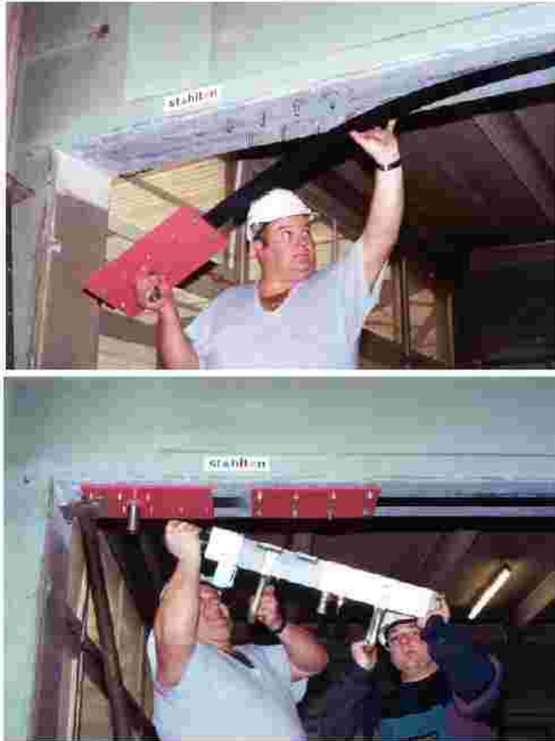
شکل ۲-۴-۱۷- روش پیش‌تنیدگی در صفحه FRP
