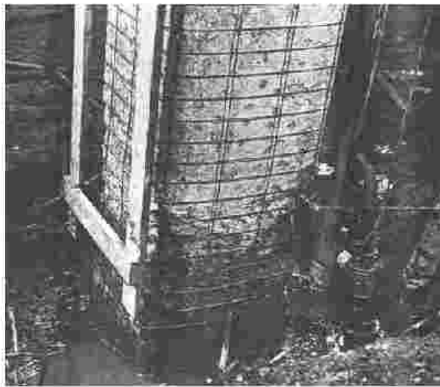
ب- اجرای روکش بتنی با بتن پاشی
