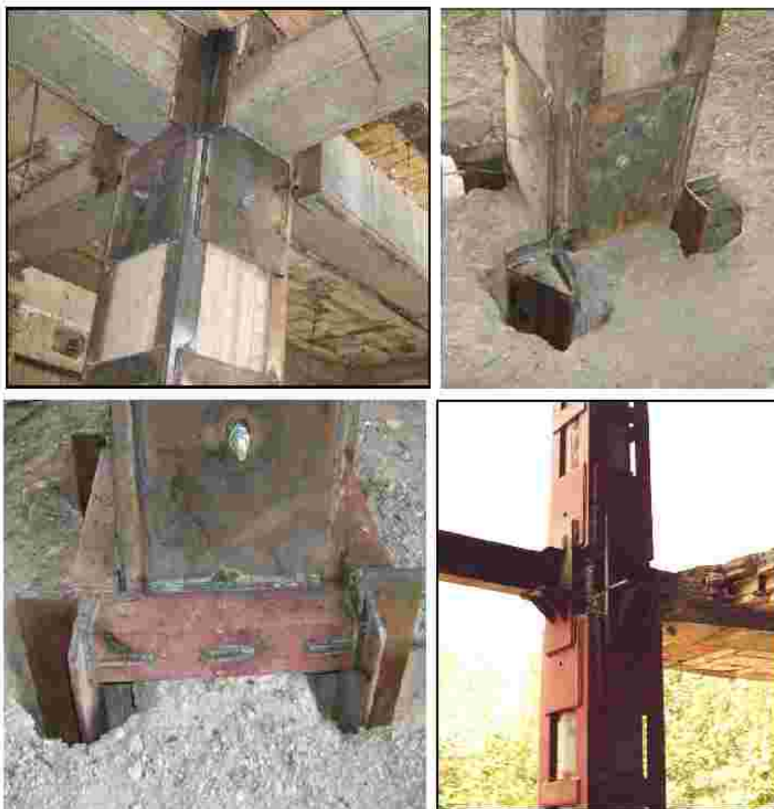
شکل ۱۲-۵-۲- نمونه‌ای از روکش فولادی جهت افزایش مقاومت خمشی ستون
