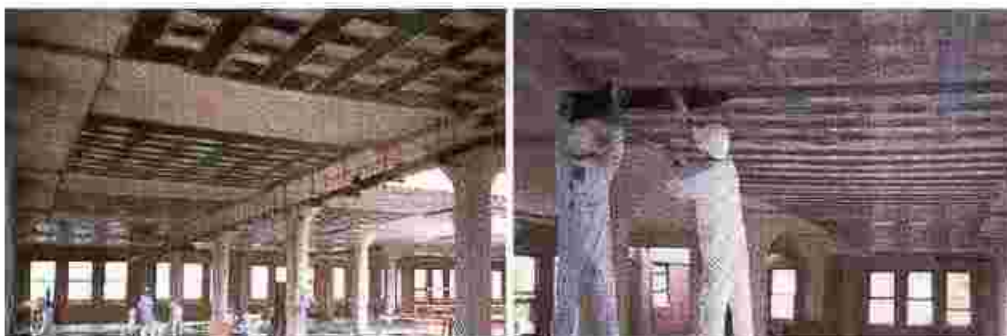
شکل ۲-۳-۹- تقویت دال با نوارهای FRP در دو جهت
