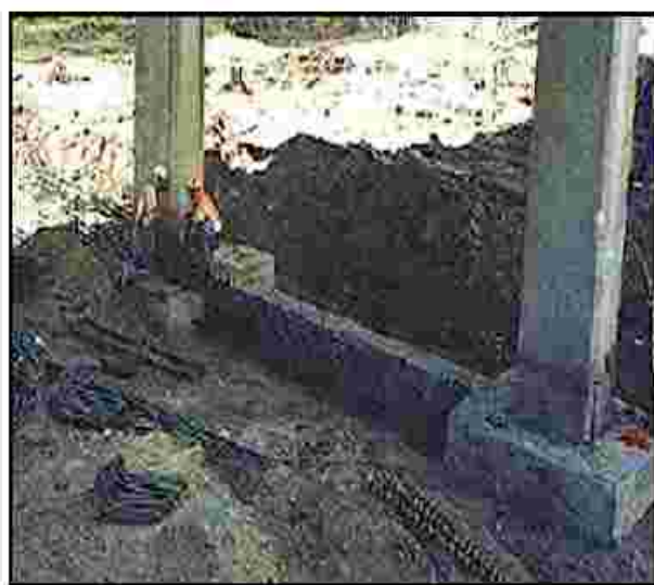
شکل ۴-۲-۲- به هم بستن شالوده‌ها با شناژ
