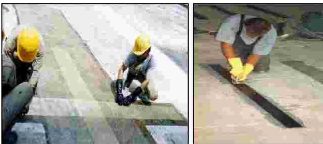
شکل ۱۱-۳-۲- مقاوم‌سازی دال در لنگرهای منفی بوسیله FRP
