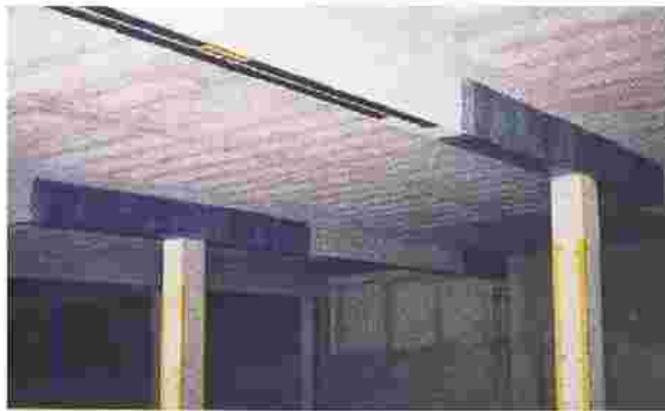
شکل ۲-۴-۸- کاربرد مصالح FRP در مقاوم‌سازی
