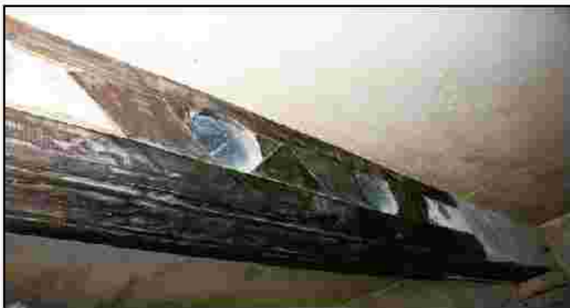
شکل ۲-۴-۱۵- تقویت موضعی سوارخ‌ها در تیر FRP
