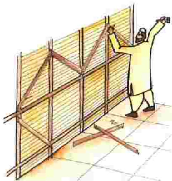
شکل ۹-۳۸ پیوستگی اعضای قطری
