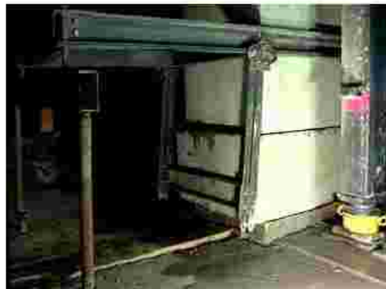
شکل ۶-۱۹ - خروج بلوک بریده شده
