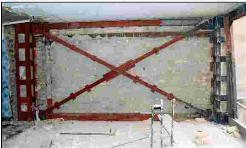
شکل ۴-۵- بهسازی قاب‌های موجود بوسیله مهاربندهای همگرا
