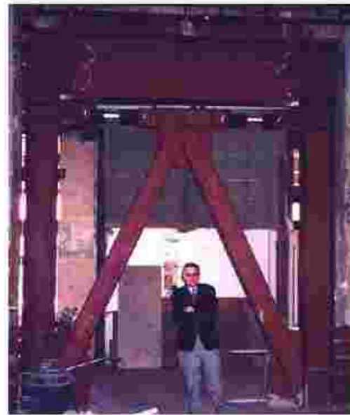
شکل ۷-۱۸- استفاده از میراگرهای ویسکوز در بادبندهای جناقی
