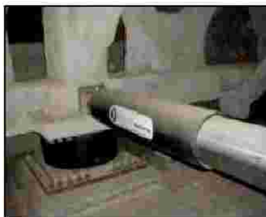
شکل ۷-۱۶- جزئیات تیب سیستم میراگر ویسکوز
