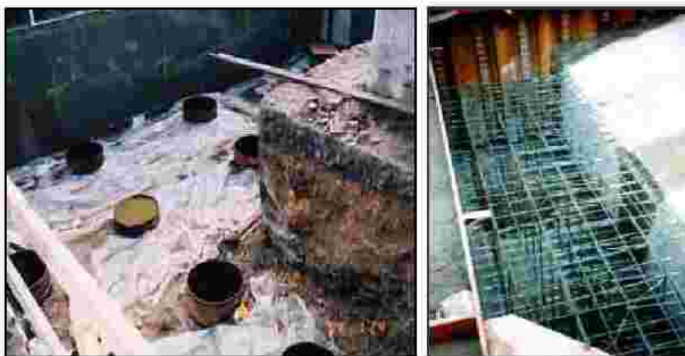
شکل ۲-۲-۱۵- مراحل اجرای شمع‌های جدید و اتصال آن به شالوده
