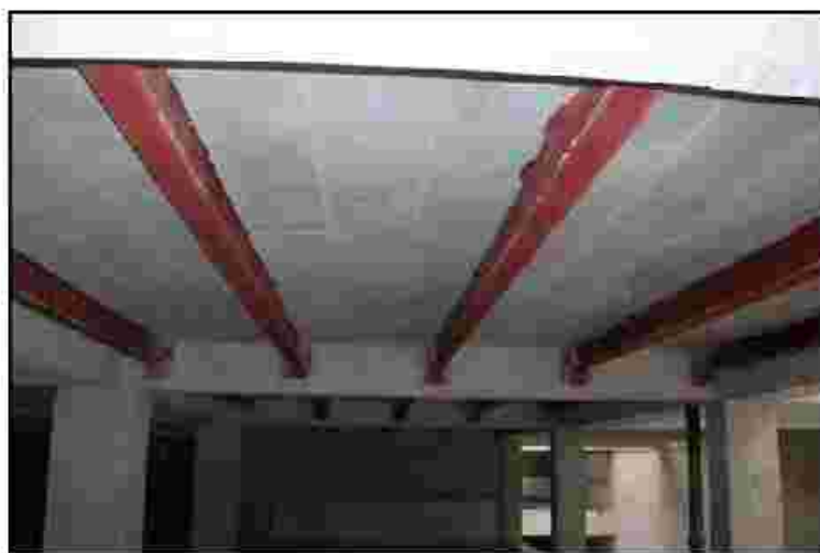
شکل ۲-۳-۵- اضافه کردن تیرک فولادی
