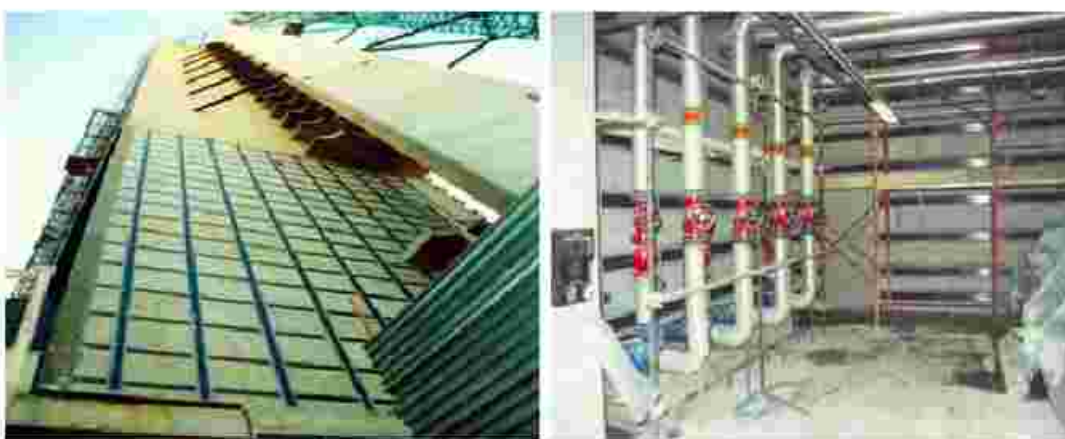
شکل ۴-۴۱- تقویت دیوار برشی با سیستم FRP
