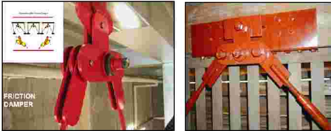
شکل ۷-۵- استفاده از میراگرهای اصطکاکی چرخشی در مقاوم سازی
