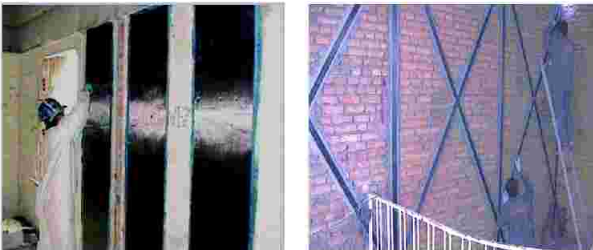
شکل ۸-۱۹ - نحوه اجرا و نصب نوارهای FRP
