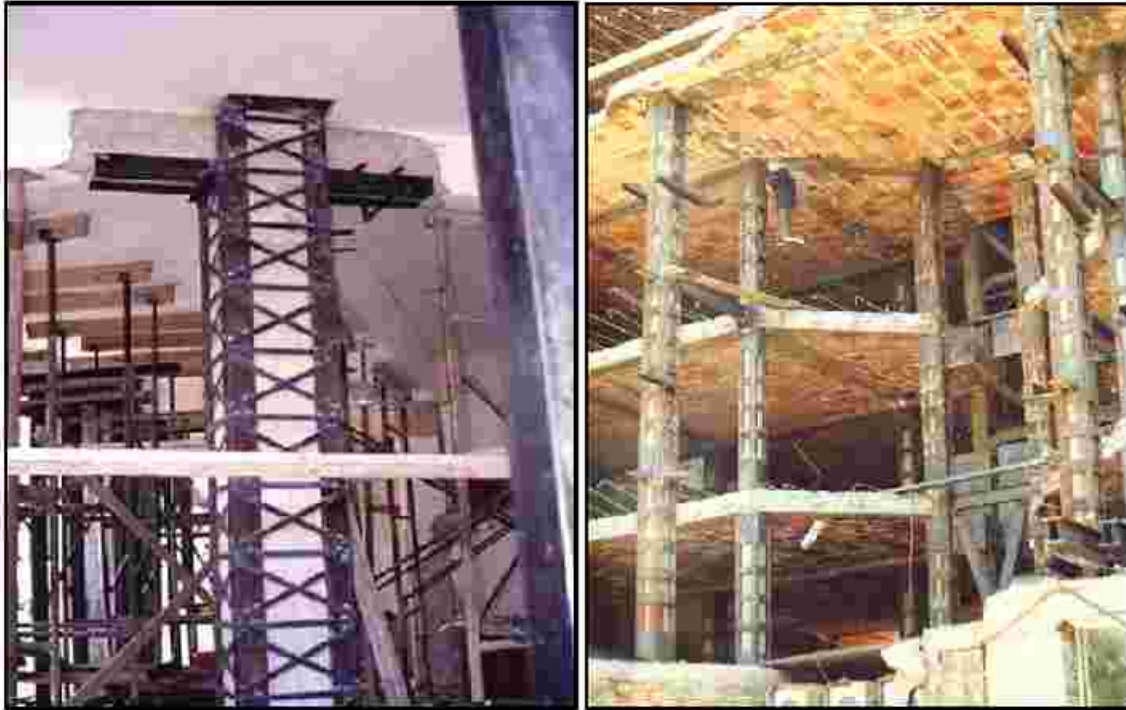
شکل ۲-۵-۱۳- بهسازی ستونهای بتنی بوسیله روکش فولادی قفسه‌ای
