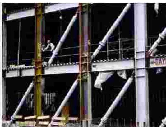
شکل ۷-۱۹- استفاده از میراگرهای ویسکوز در بادبندهای قطری
