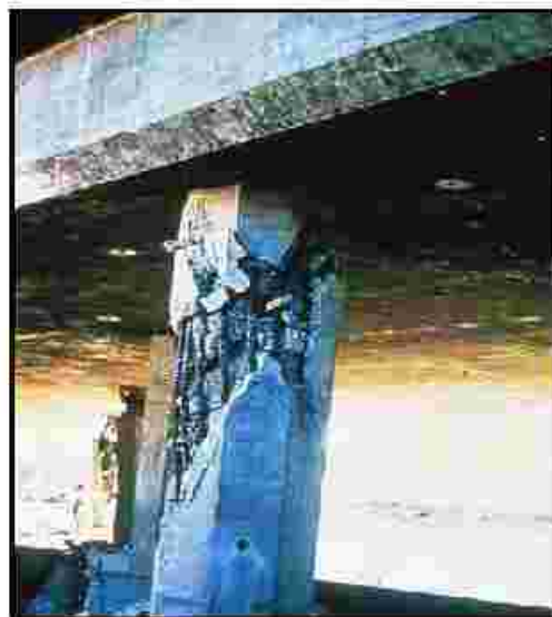
شکل ۲-۵-۱- نمونه‌ای از شکست برشی ستون
