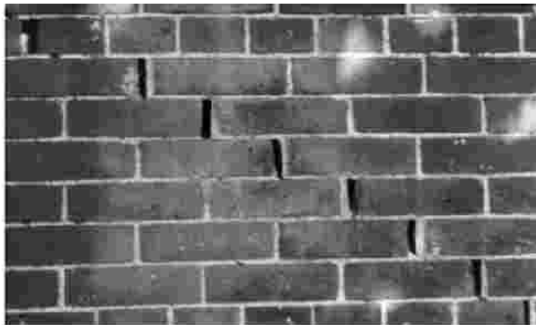
شکل ۸-۵- لغزش درز مالات پس از ترک خوردگی قطری
