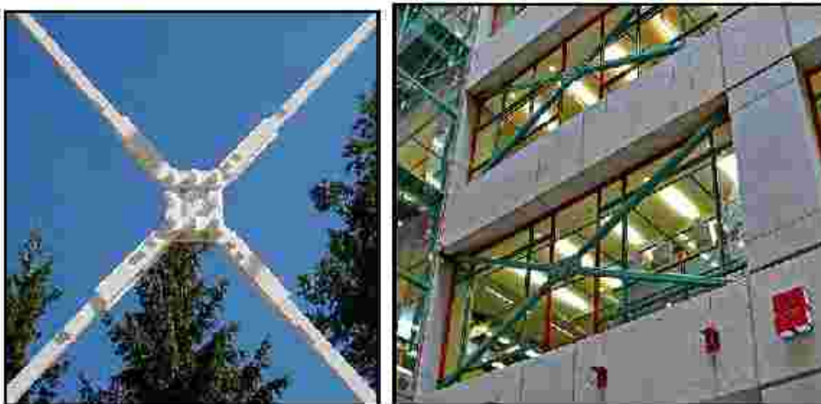
شکل ۷-۶- استفاده از میراگرهای اصطکاکی پال (Pall) در مقاوم سازی
