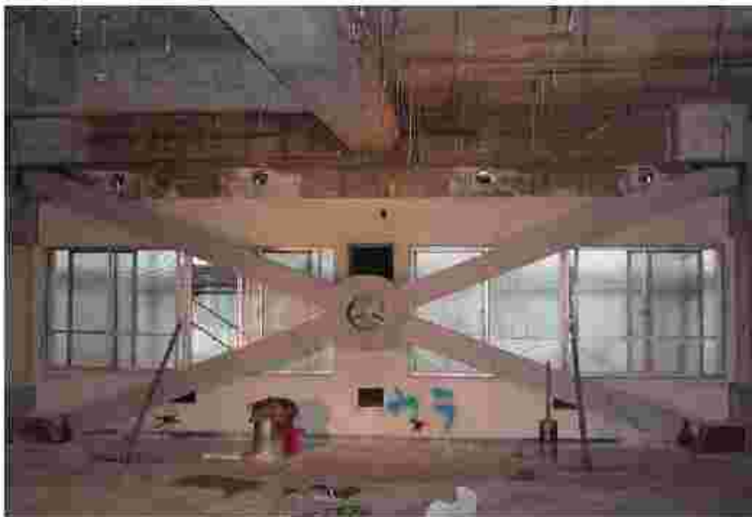
شکل ۴-۲۳ - نمونه‌ای از مهاربند بتنی پیش‌تنیده و پیش‌ساخته
