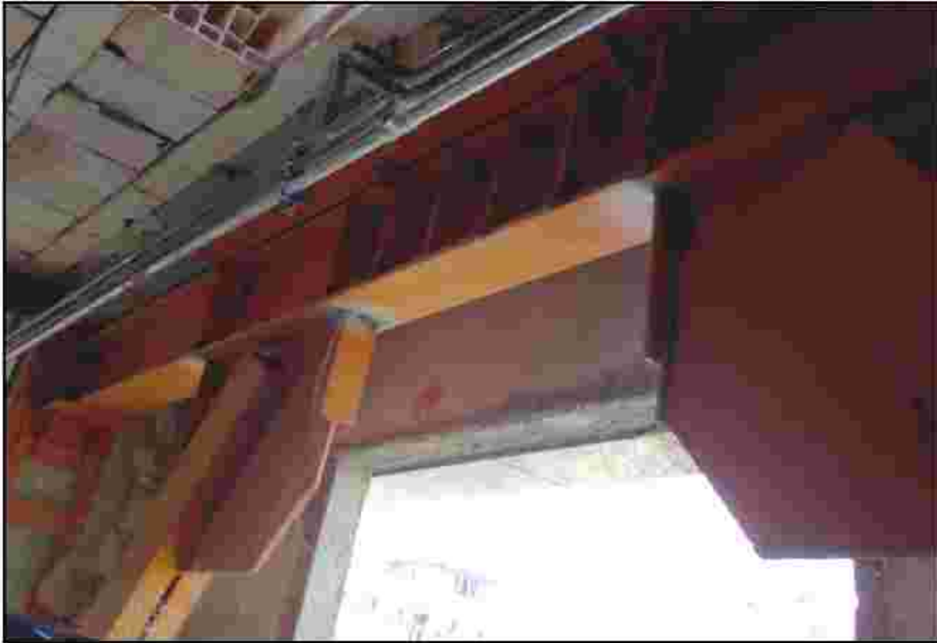
شکل ۴-۱۵- اضافه کردن مهاربند و اگرچه قاب‌های موجود ساختمان
