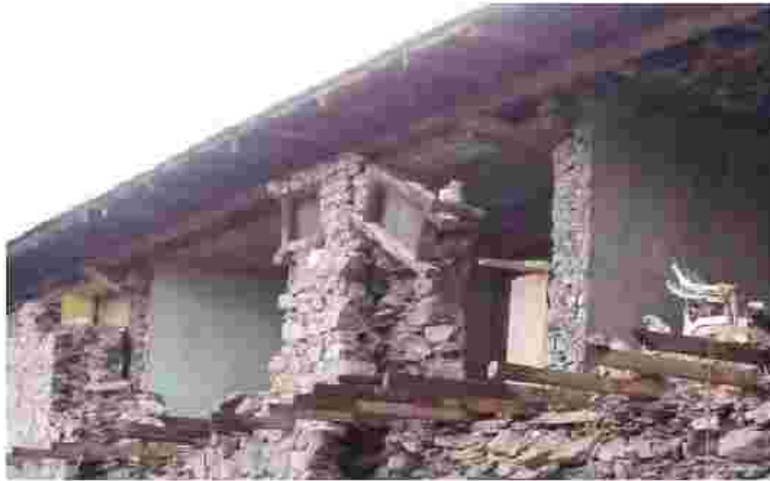
خرابی به علت ضعف در مقاومت خمشی دیوارهای بتابی
