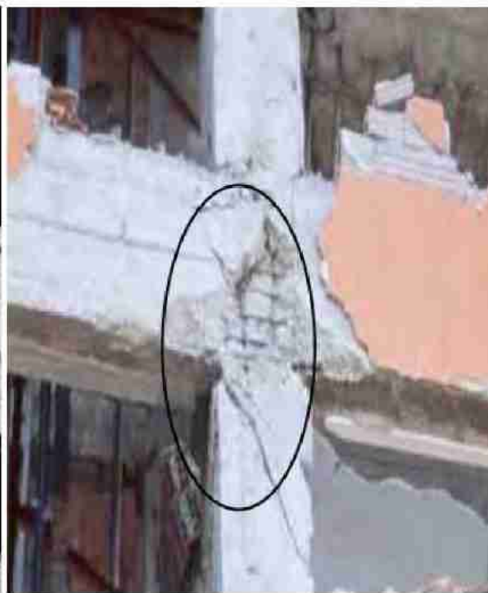
گسیختگی برشی در ناحیه ستون در بر اتصال
