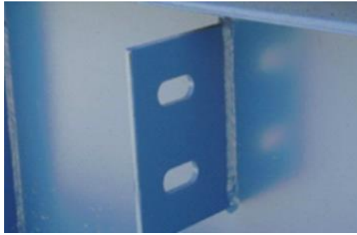
شکل ۱۰-۱۴ سوراخ لوبیایی
